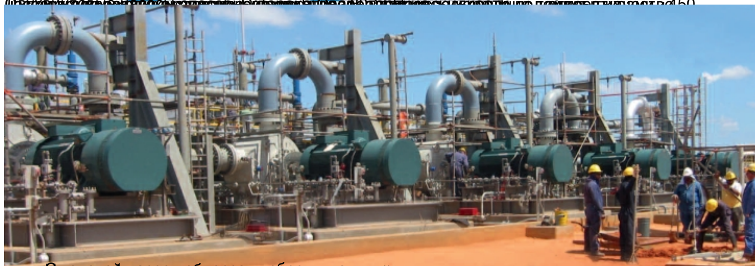
Рисунок 1.4. Двухвинтовой мультифазный насос для перекачки жидкой нефти с газом (масло) и твердыми частицами (песок).
